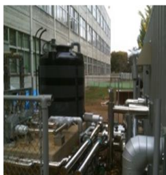
地下水を利用した次世代型ヒートポンプ空調 工学部共通教育等2F(3部屋)に当該システムを導入し、システムの実証と、二酸化炭素削減の量の評価を実施している。
